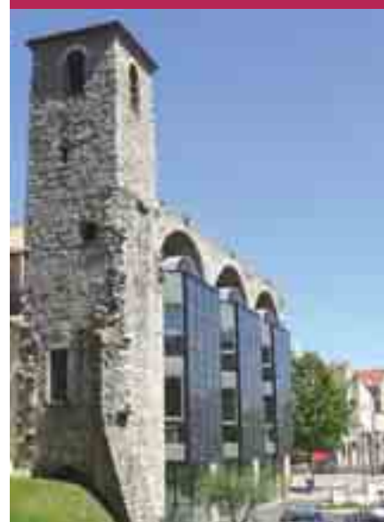
Exemple unique d'utilisation du concept de double peau intégrant un dispositif photovoltaïque, la Maison du Tourisme et des Cévennes.
