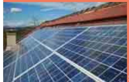
Installation de modules Photowatt dans le cadre du projet HipHip.
