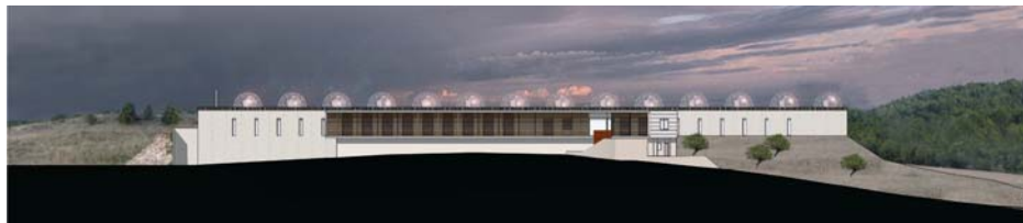
Figure 1 – Maquette de la façade sud du futur Ecotron Européen de Montpellier. © MDR architectes / Auvertech. En haut, on distingue les « dômes de verre » (macrocosmes) dans lesquels seront confinées et étudiées les portions d'écosystèmes.
