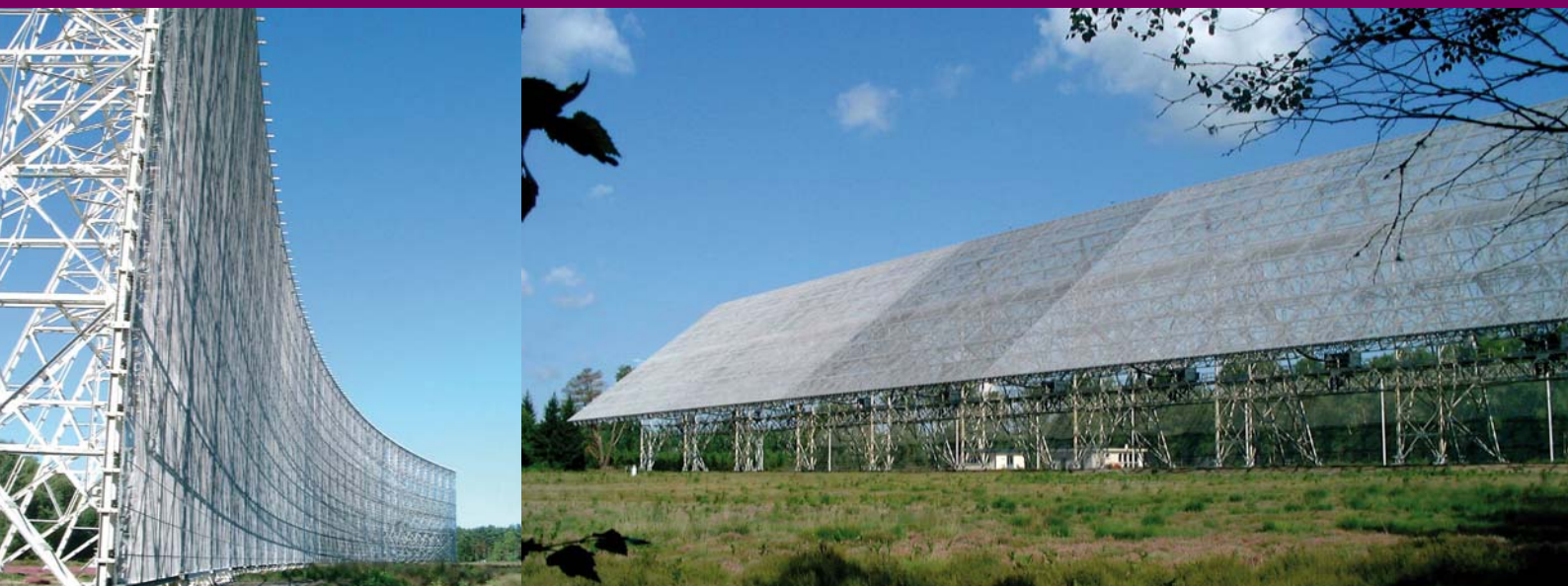
Le miroir fixe du radiotélescope décimétrique renvoie en concentrant les ondes sur le chariot focal. Sa forme sphérique est de 560m de rayon.
