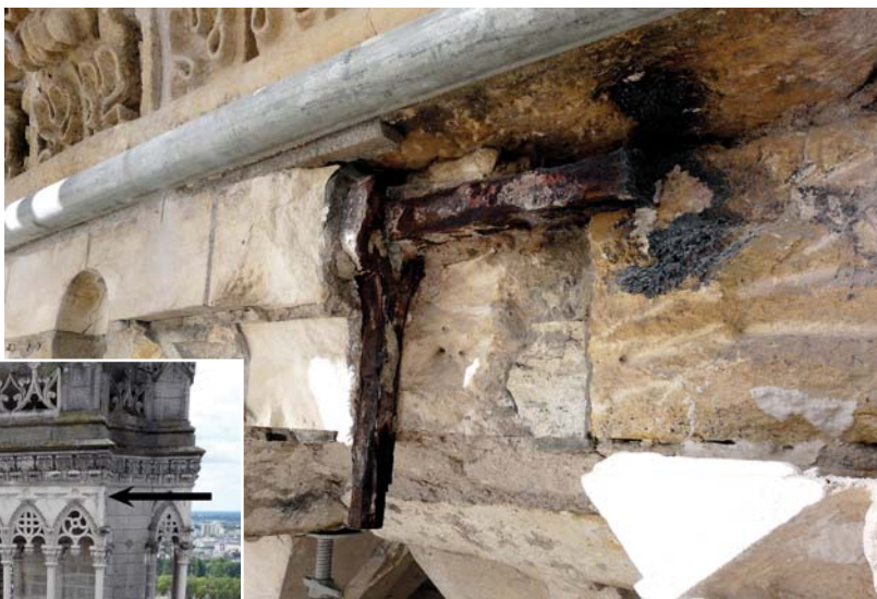
Chaînages périphériques au deuxième étage des tours de façade de la cathédrale Sainte-Croix d'Orléans. Grâce à ce système, la partie supérieure de l'étage est entièrement autoportée : théoriquement, aucun poids ne repose sur les colonnes. Lors des restaurations, ces chaînages ont été déposés et remplacés. Leur altération sera étudiée dans le cadre du projet FECOMEDA.
