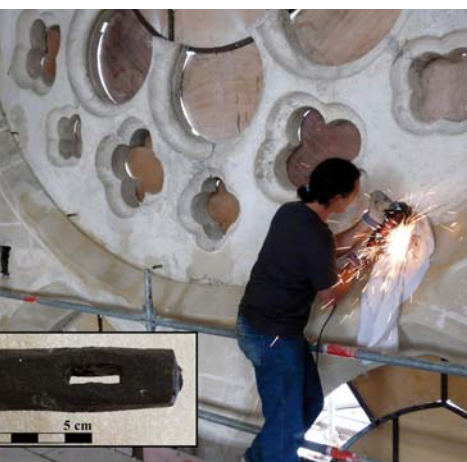
Prélèvement des tenons et crochets autour des oculi des baies hautes du cœur de la cathédrale Notre-Dame de Chartres lors de la campagne de restauration à l'été 2009.
