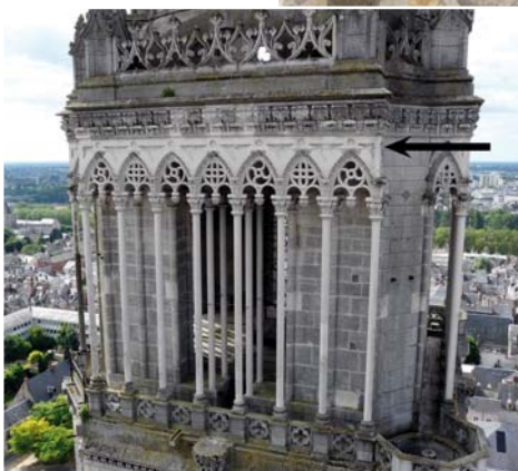
Chaînages périphériques au deuxième étage des tours de façade de la cathédrale Sainte-Croix d'Orléans. Grâce à ce système, la partie supérieure de l'étage est entièrement autoportée : théoriquement, aucun poids ne repose sur les colonnes. Lors des restaurations, ces chaînages ont été déposés et remplacés. Leur altération sera étudiée dans le cadre du projet FECOMEDA.
