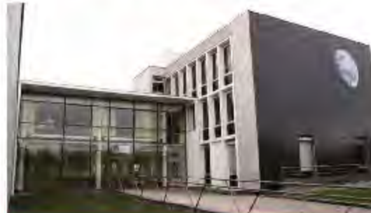
Site LPC2E, sur le campus ORLEANS
